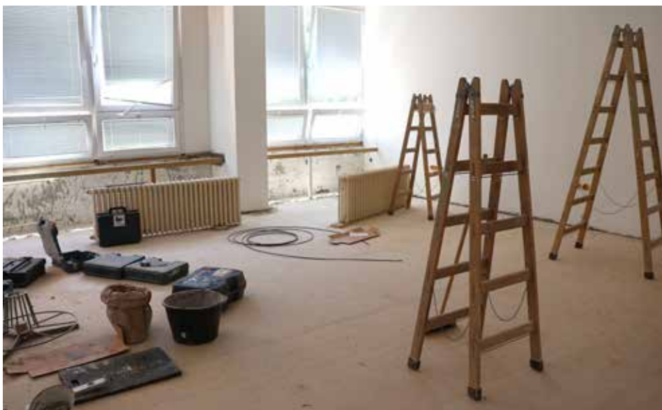
Škola o prázdninách nespí, probíhají zde stavební úpravy...
