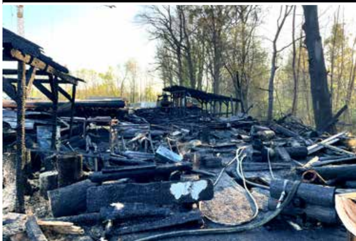
Rozsáhlý požár v areálu firmy Sruby Pacák
