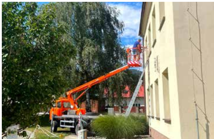
Instalace klimatizace si vyžádala vysokozdvížnou plošinu
